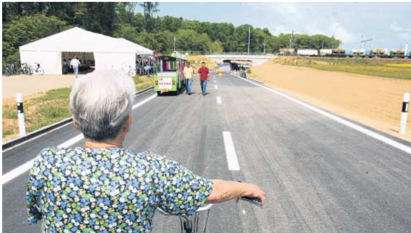
Bald befahrbar. In drei Wochen wird der Verkehr über die NK 495 rollen. Foto Dominik Plüss
